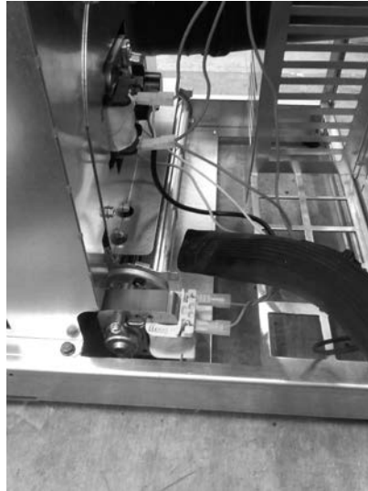
Fig. 35 - Reiniging omgevingsventilator
